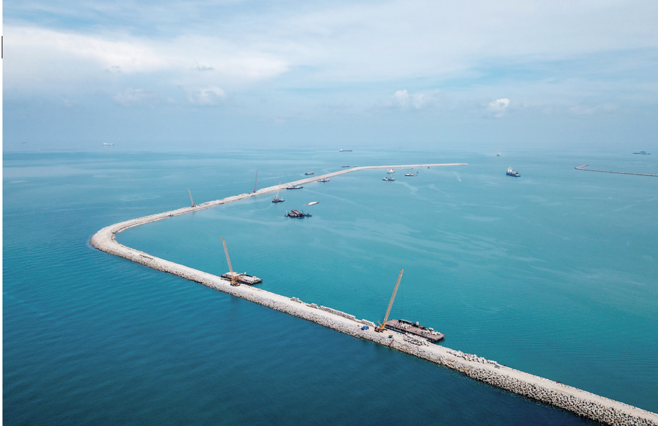
“一带一路”的落实和推进，有助于拉紧中国与周边国家关系的纽带，促进周边地区的共同发展。中国企业陆续走向海外，主持或承建了一大批基础设施项目，为改善沿线国家基础设施条件、带动当地经济社会发展发挥了积极作用。为支撑配合马中关丹产业园区的发展，广西北部湾国际港务集团有限公司入股关丹港后与马方合作伙伴一起加快了对关丹港进行升级改造。图为2018年4月28日在马来西亚关丹港新深水码头拍摄的防波堤。
